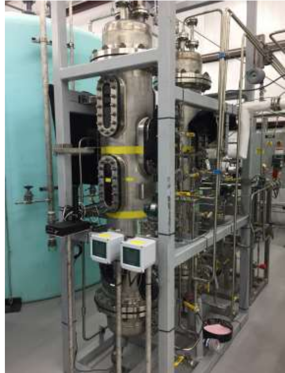
Fig.4. IX Column Skid
